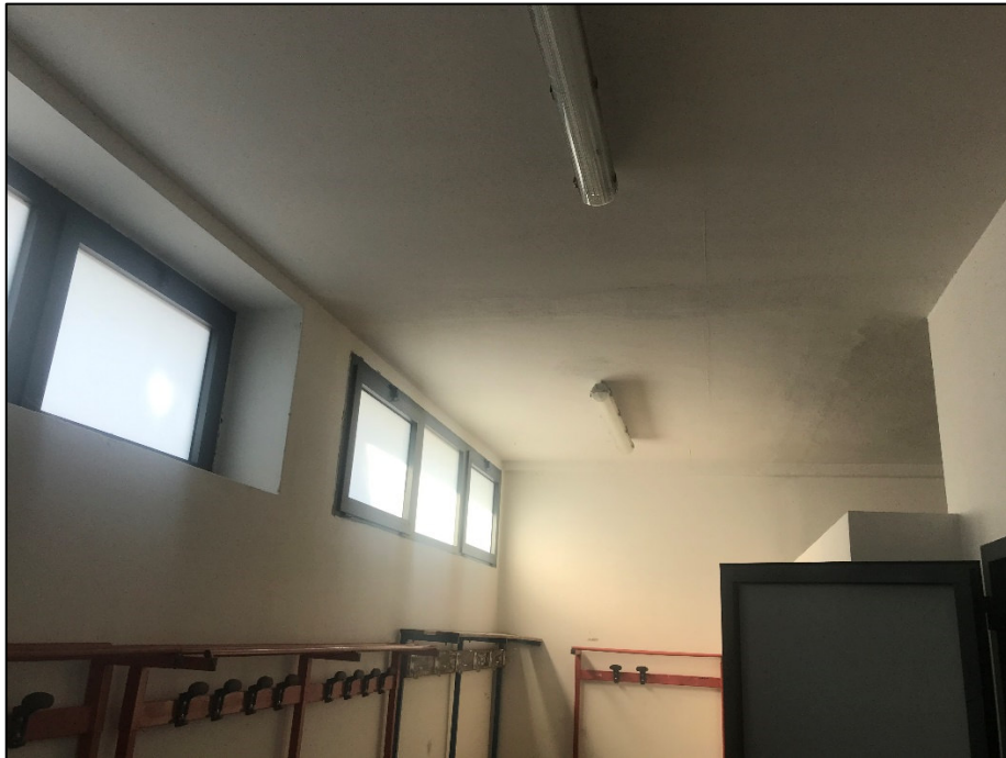
Figura 5 – Interno degli spogliatoi
