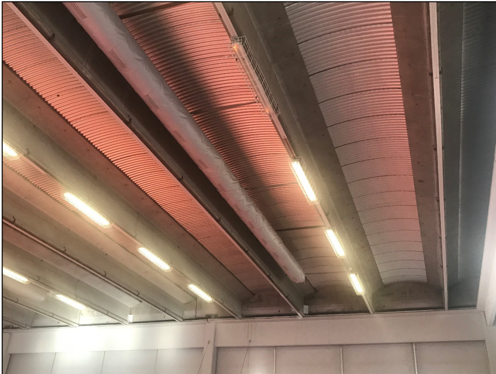
Figura 7 – Particolare della copertura
