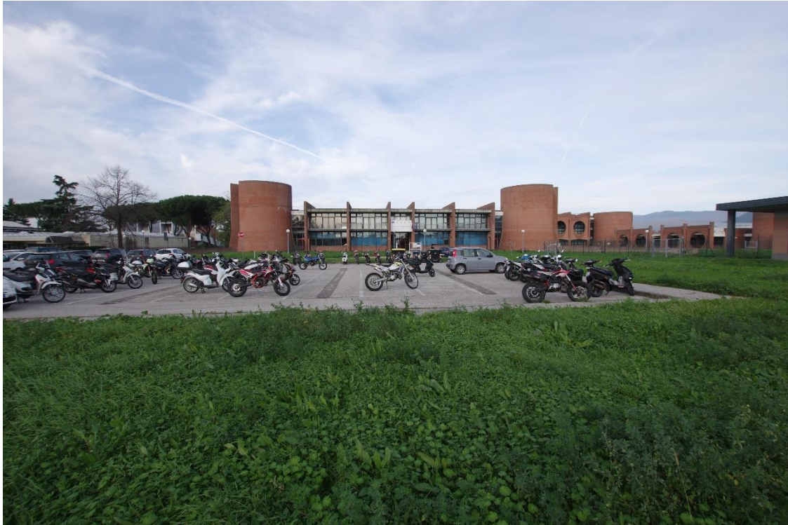
Foto 3 - Parcheggio esistente lato Sud Ovest
