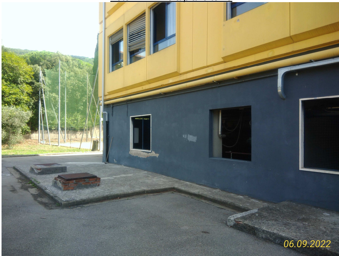
Foto n° 3 – Area di cantiere esterna
