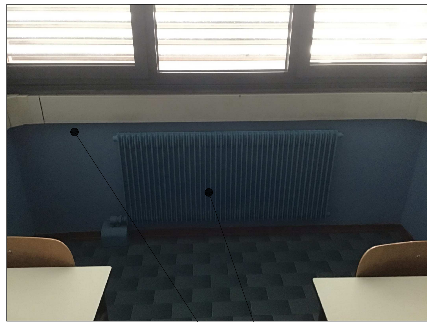
SMONTAGGIO E RIMONTAGGIO DI RADIATORE ESISTENTE PER IL PASSAGGIO DELLE NUOVE TUBAZIONI INSTALLAZIONE DI NUOVA CANALINA IN PVC PER PASSAGGIO TUBAZIONI IMPIANTO RADIATORI SOTTO CANALINA ELETTRICA ESISTENTE
