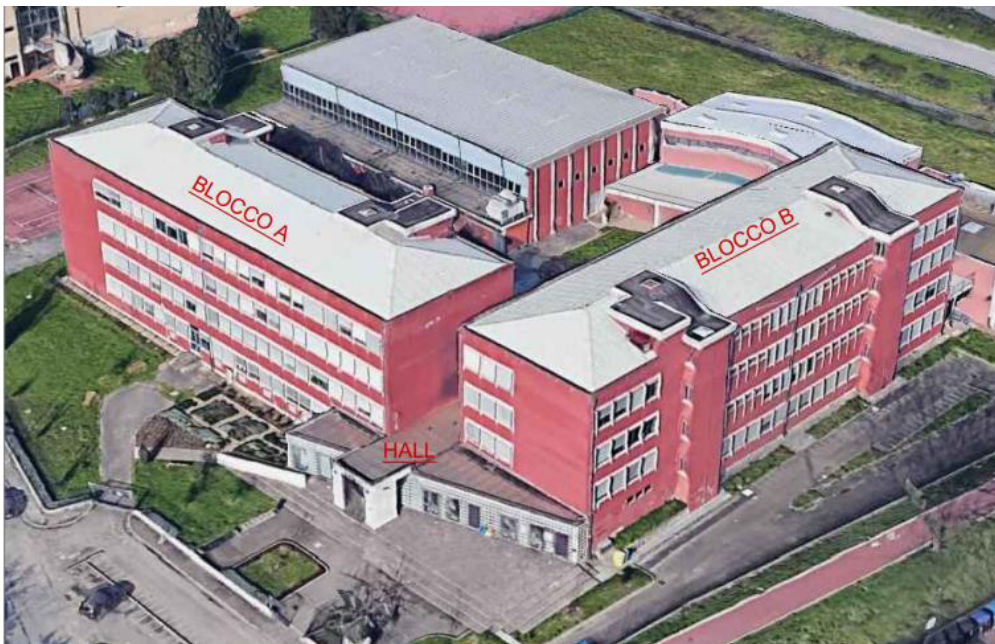
Figura 1 - Vista d'insieme dell'edificio e individuazione dei blocchi
