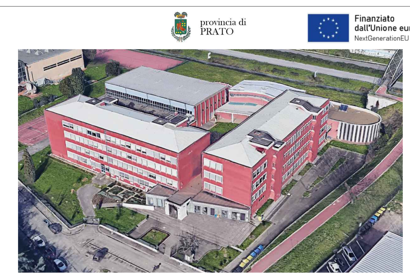
INTERVENTO DI ADEGUAMENTO SISMICO DEL FABBRICATO SEDE DELLA SCUOLA SECONDARIA SUPERIORE P. DAGOMARI DI PRATO
