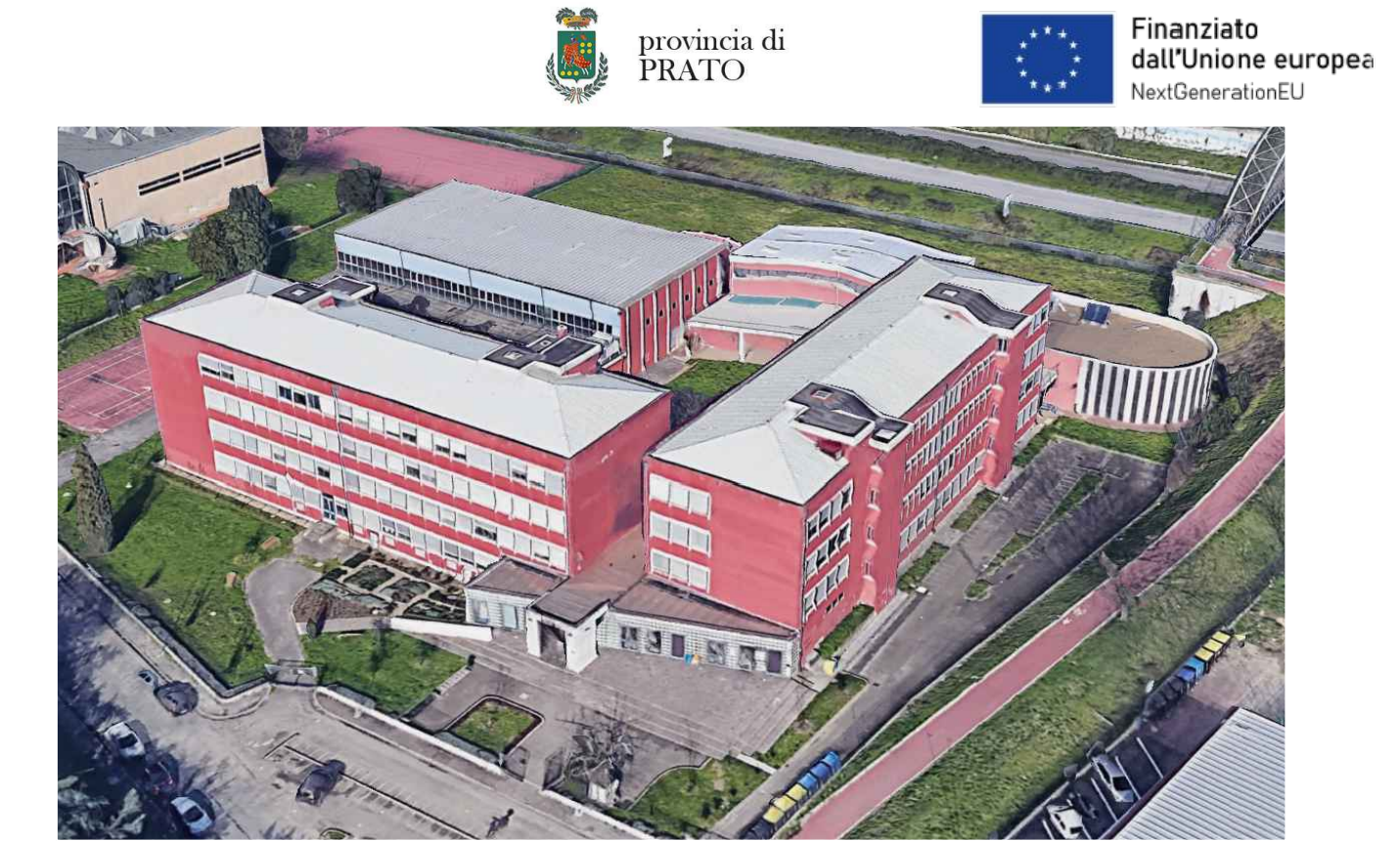
INTERVENTO DI ADEGUAMENTO SISMICO DEL FABBRICATO SEDE DELLA SCUOLA SECONDARIA SUPERIORE P. DAGOMARI DI PRATO
