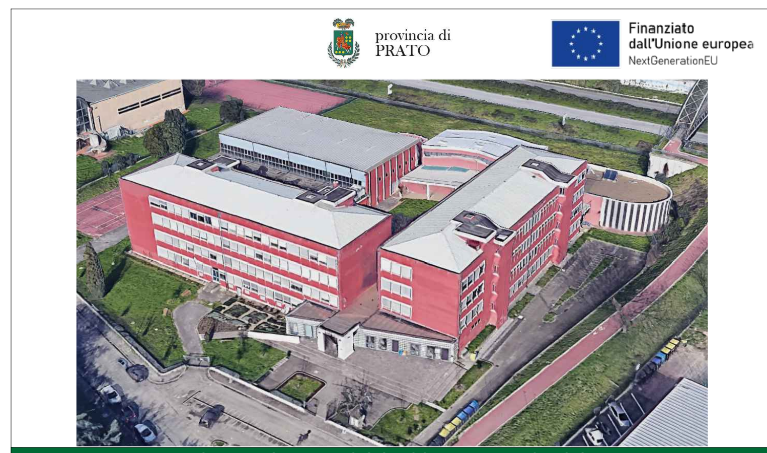
INTERVENTO DI ADEGUAMENTO SISMICO DEL FABBRICATO SEDE DELLA SCUOLA SECONDARIA SUPERIORE P. DAGOMARI DI PRATO
