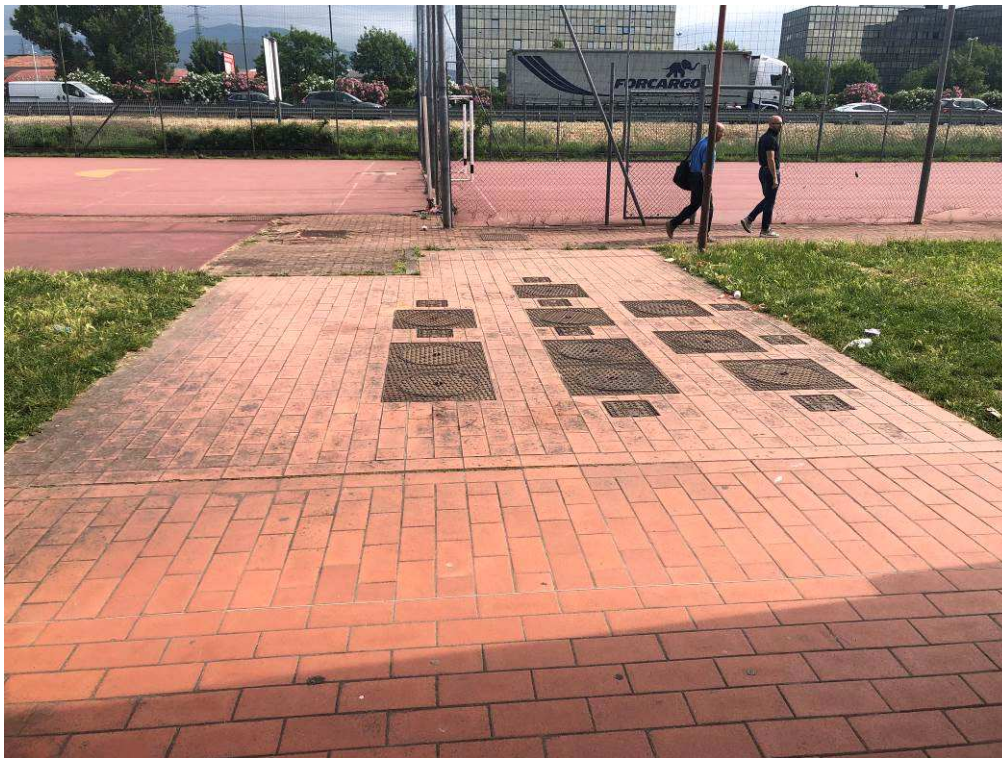
Fig. 2 – Copertura vano tecnico fossa biologica n° 1
