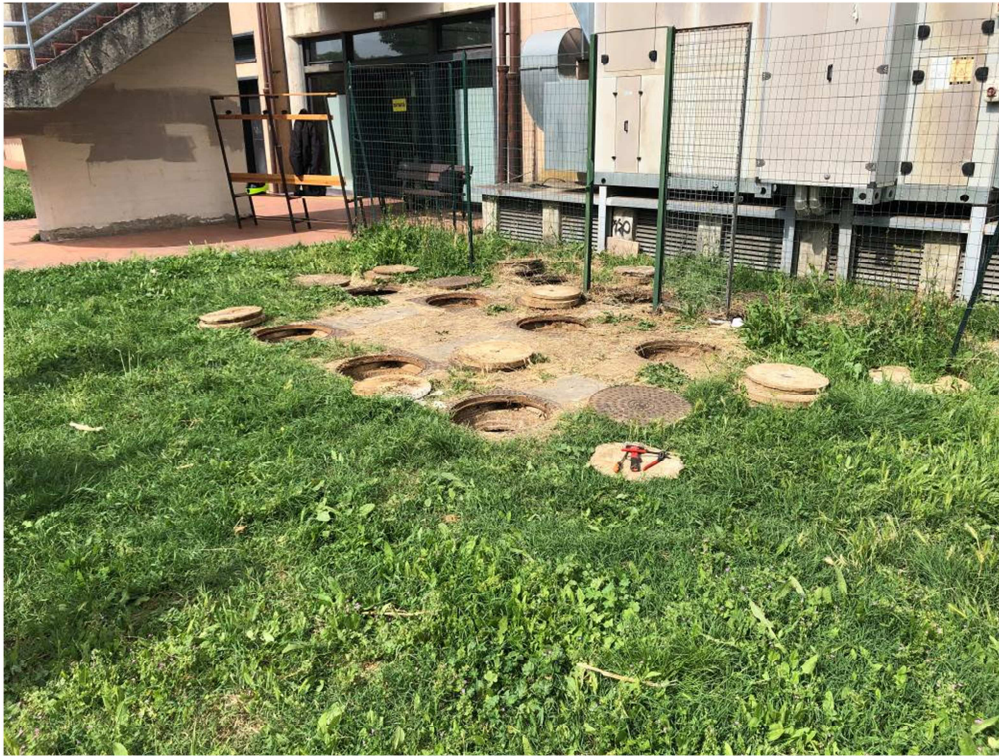
Fig. 4 – Copertura vano tecnico fossa biologica n° 2
