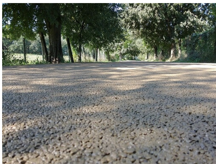
Pavimentazione drenante tipo Ecodrain o equivalente
