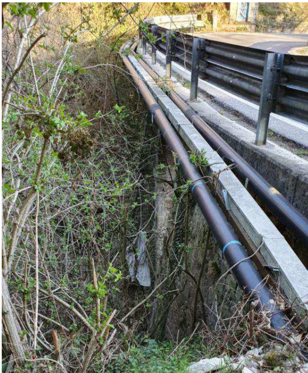
Lato sinistro del ponte
