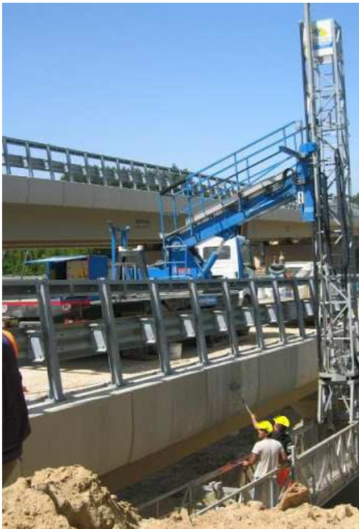
esempio lavorazione con bay-bridge
