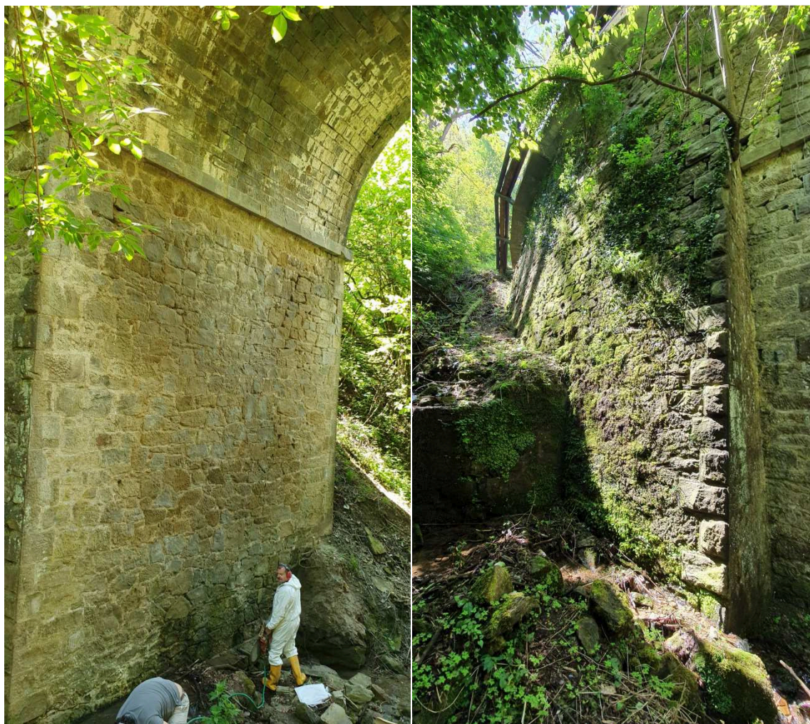
Spalle in muri verticali e contrafforti di pietra
