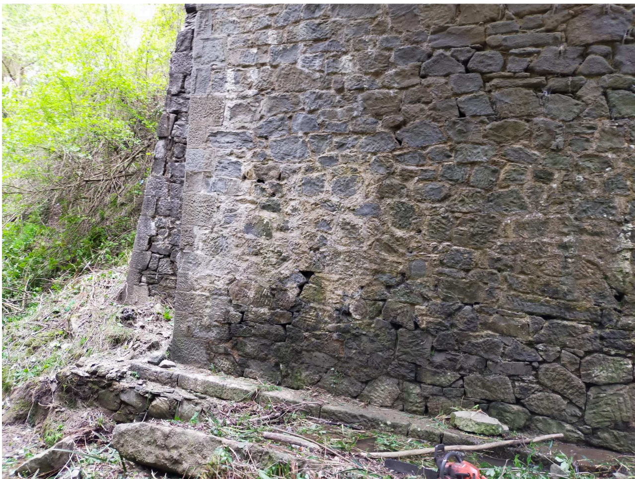
Fondazioni di tipo diretto superficiale in muratura di pietre
