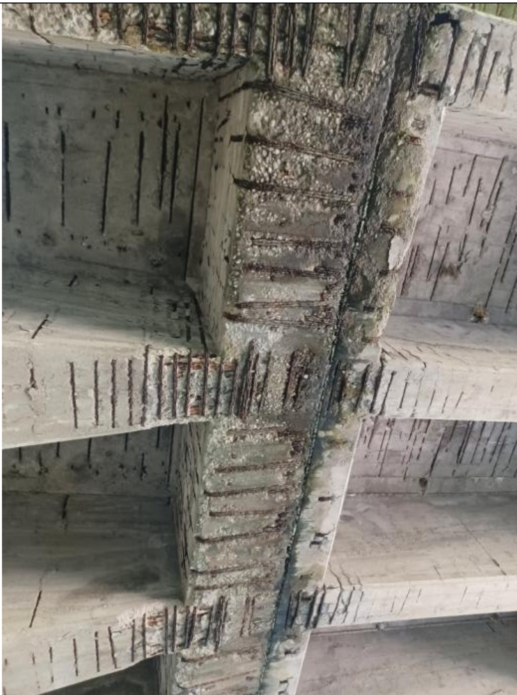
Foto 12 del 13/10/2021 Vista da sotto della campata del ponte all'altezza della sella. Non sono state individuate sulla struttura aree di nidificazione o riparo.
