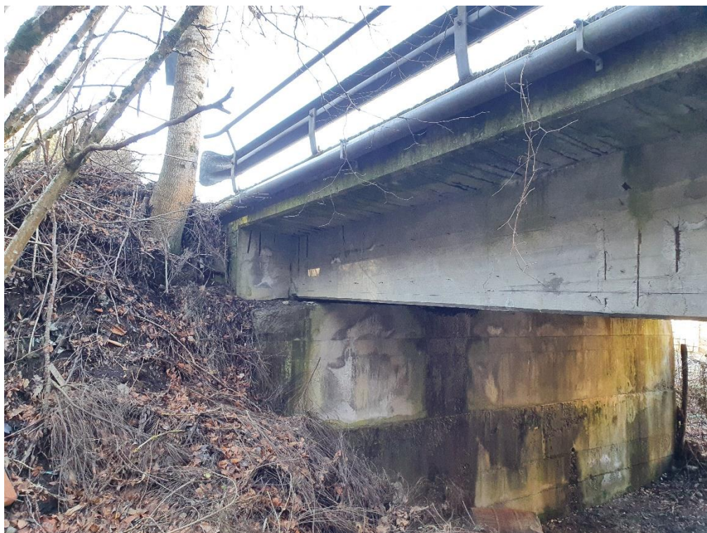
Figura 1. Interferenza rilevata da E-DISTRIBUZIONE, con linea MT staffata sul ponte, lato valle.
