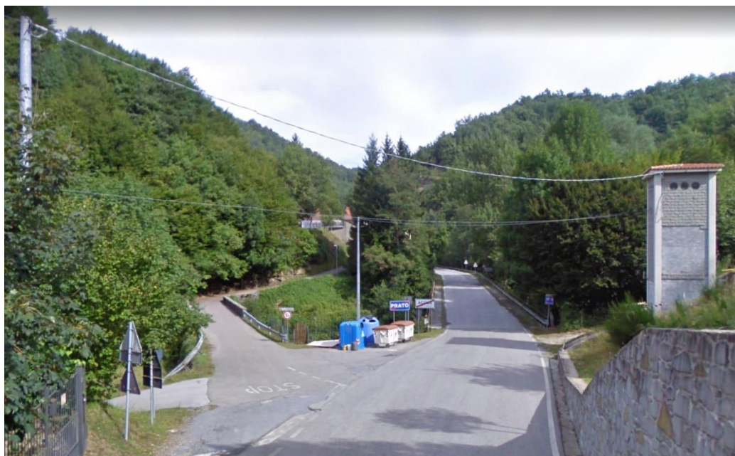
Figura 2. Presenza di linee aeree-cabina elettrica.
