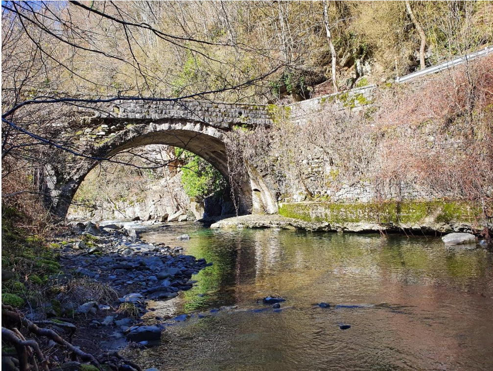
Figura 7. Vista attuale del ponte ad arco, già esistente nel 1963.
