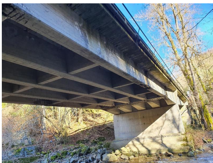
Figura 9. Viste del ponte oggetto di intervento.
