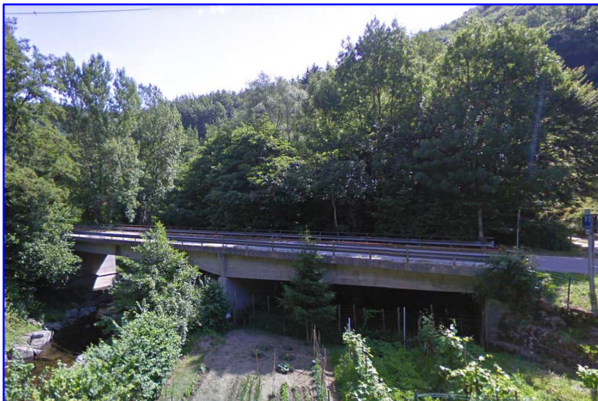
Ponte Limenta – località L'Acqua, Comune di Cantagallo (PO)
