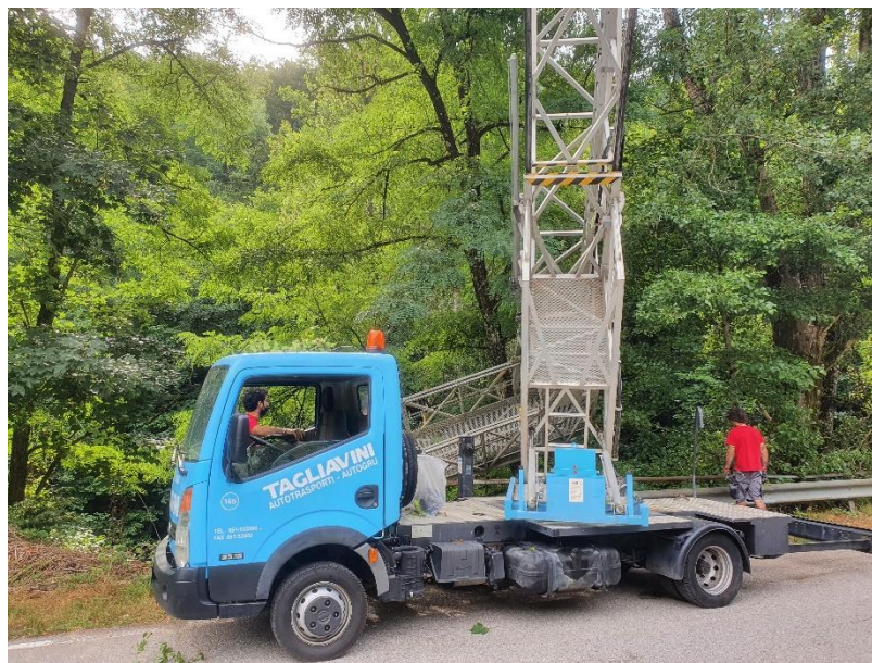
Figura 1. Posizionamento del bybridge per l'esecuzione di prove.
