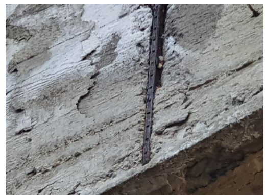
Figura 10. Ferro tipo estratto per la struttura in esame.
