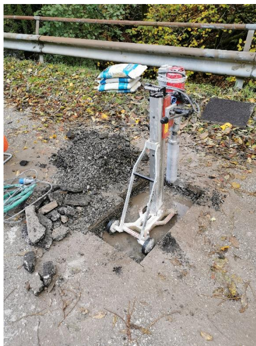
Figura 6. Carotatrice posizionata per estrazione in corrispondenza della soletta strutturale
