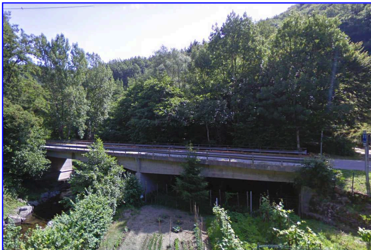
Ponte Limentra – località L'Acqua, Comune di Cantagallo (PO)
