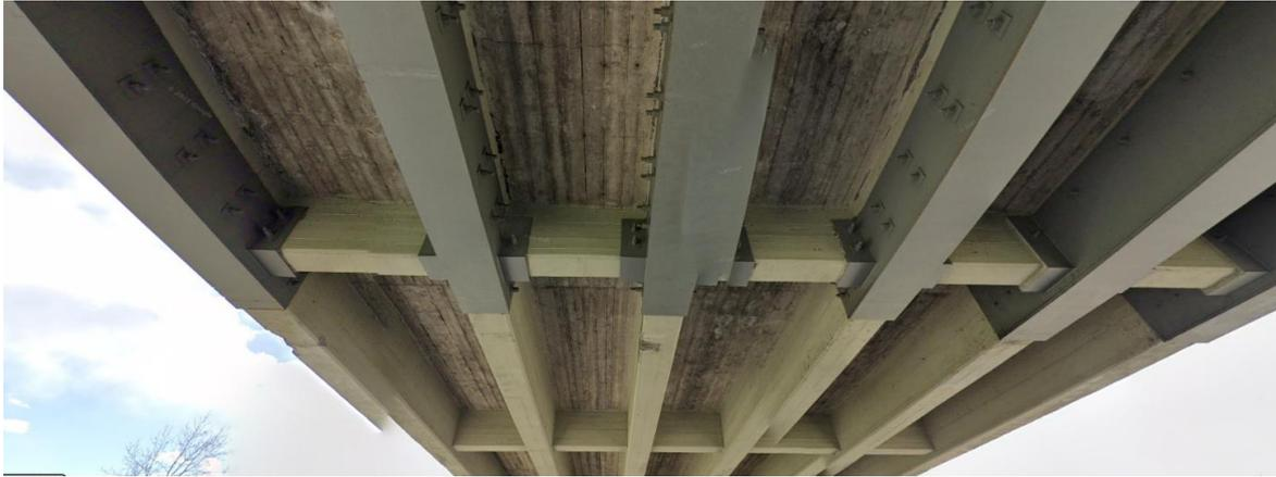
*Figura 3. Esempio di incamiciatura realizzata su impalcato da ponte in Viale Leonardo da Vinci-Prato (PO).*
