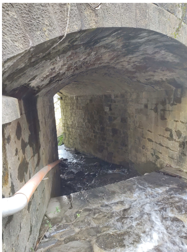
FOTO 3: INTERNO DEL PONTE
