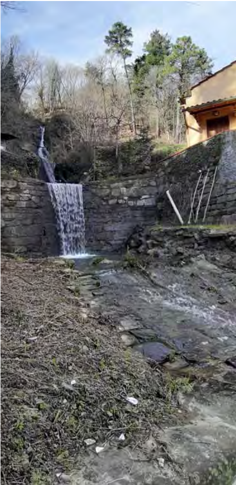
sistemazioni dell'alveo a monte dell'attraversamento stradale
