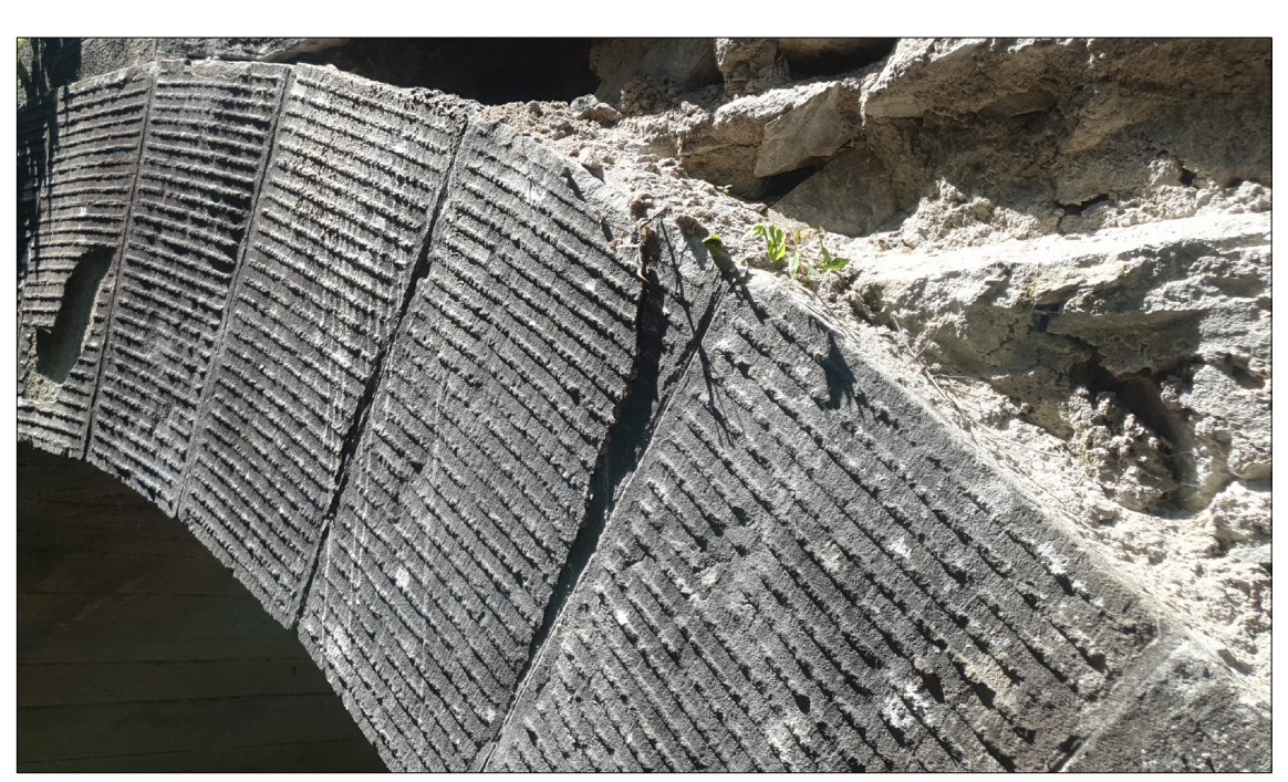
particolare ghiera di rivestimento arco in cls in conci perfettamente squadrate con piano boccardato
