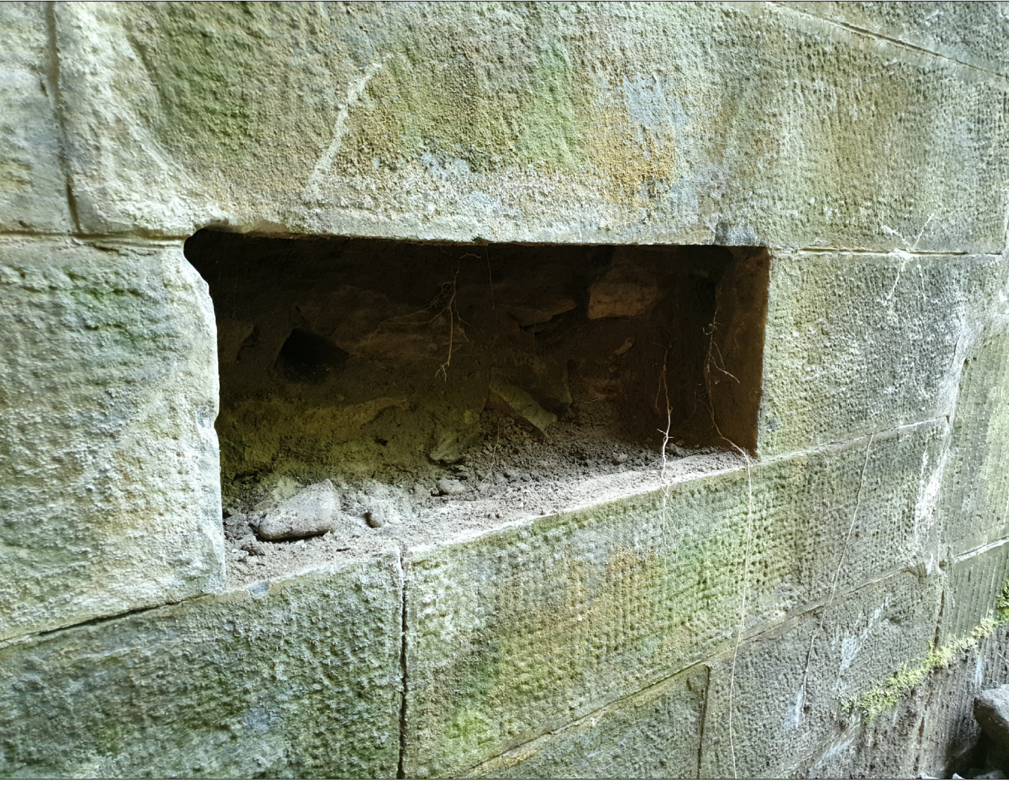
particolare paramento tipo A in bozze perfettamente squadrate con piano boccardato
