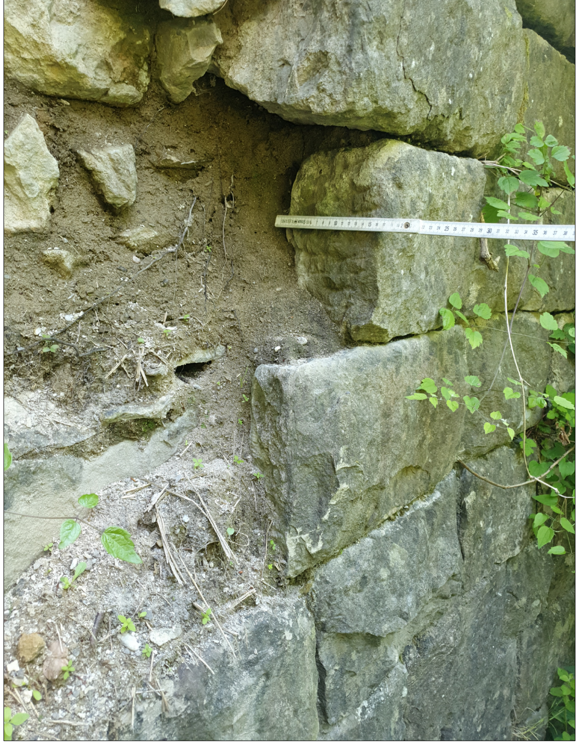
particolare paramento tipo B in bozze squadrate con piano bugnato
