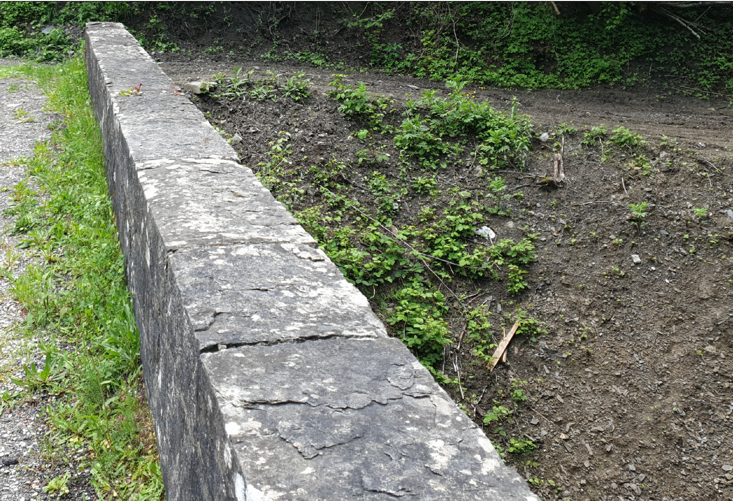
particolare cimasa alla sommità dei parapetti
