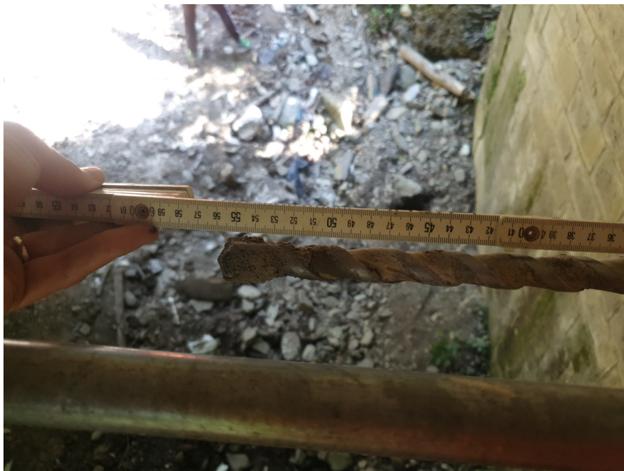
Saggio all'imposta della volta in cls
