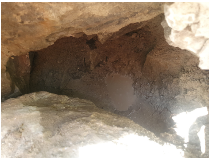
Saggio sullo spessore della volta di cls in chiave
