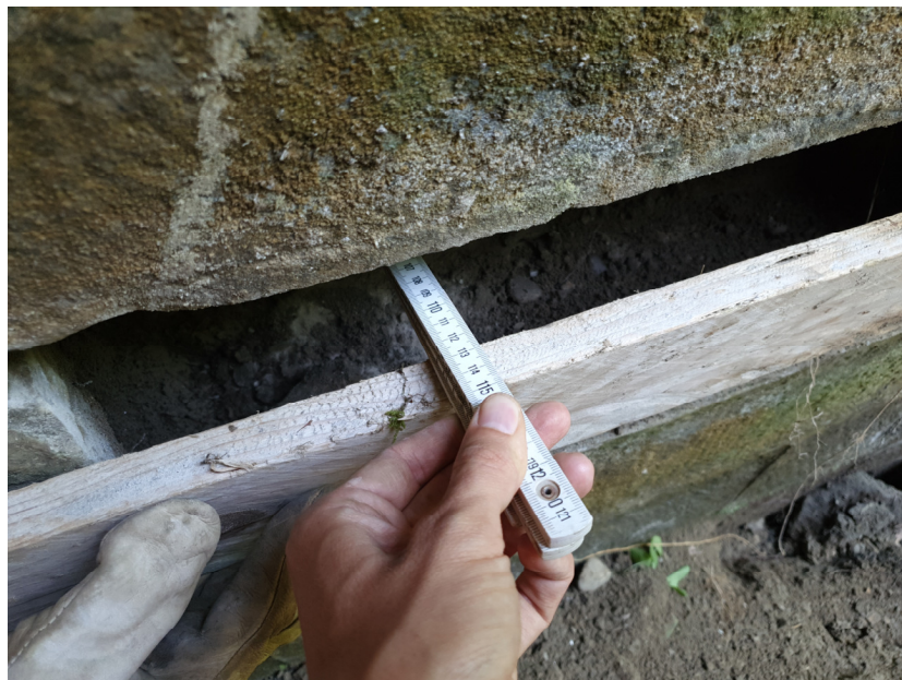
Saggio sulla muratura delle spalle
