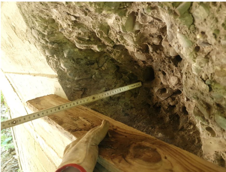
Saggio all'imposta della volta in cls
