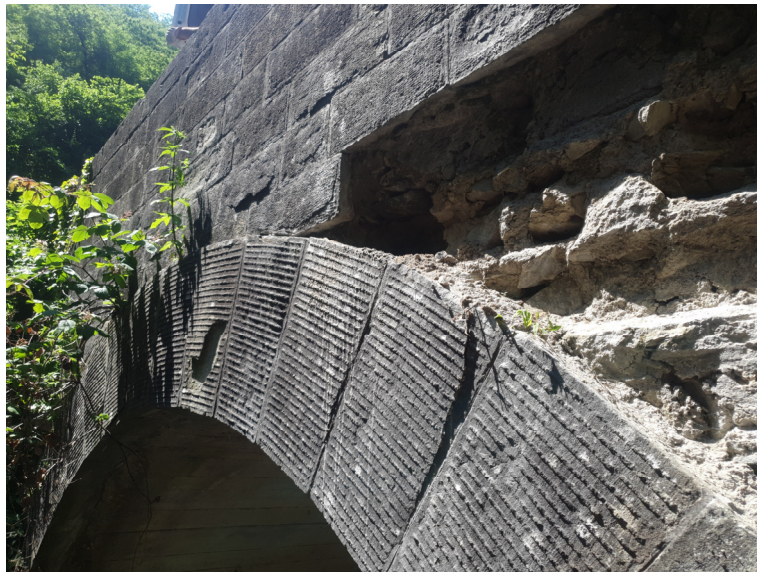
Saggio sulla muratura di timpano
