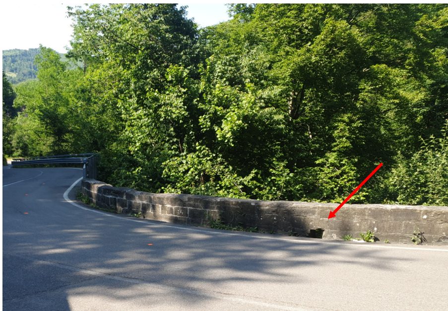
Bocchette di scarico nel torrente delle acque di piattaforma sul parapetto di valle
