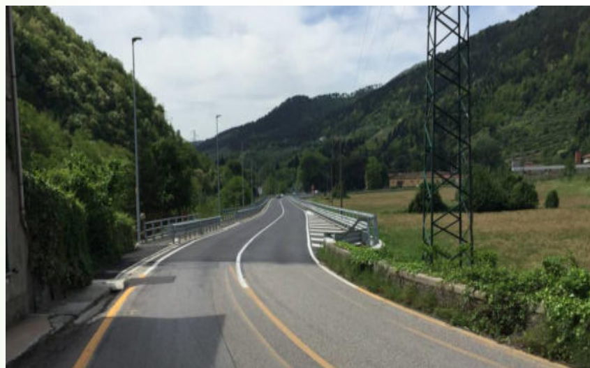
Vista tratto di strada completato lato sud curva
