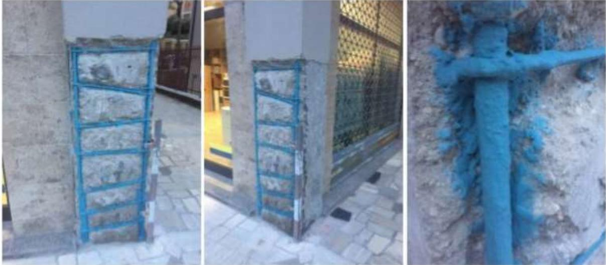
Successivamente si dovrà provvedere a ripristinare il copriferro in calcestruzzo e, in base ai risultati delle analisi sui materiali, potrà essere prevista l'applicazione di più strati sovrapposti di FRP in fibra di carbonio.
