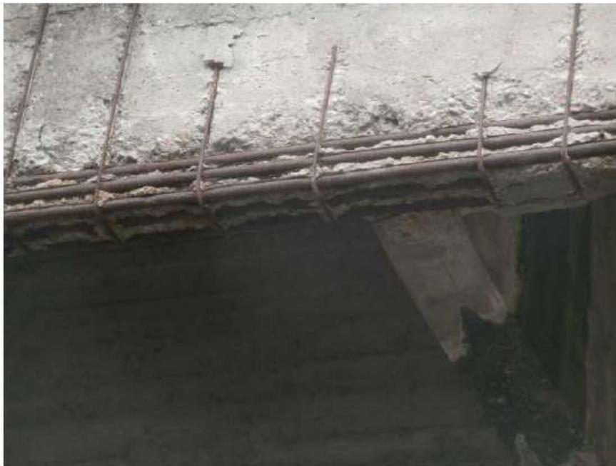
*Figura 1: distacco dei copriferrì e armatura ossidata delle travi in CA*
