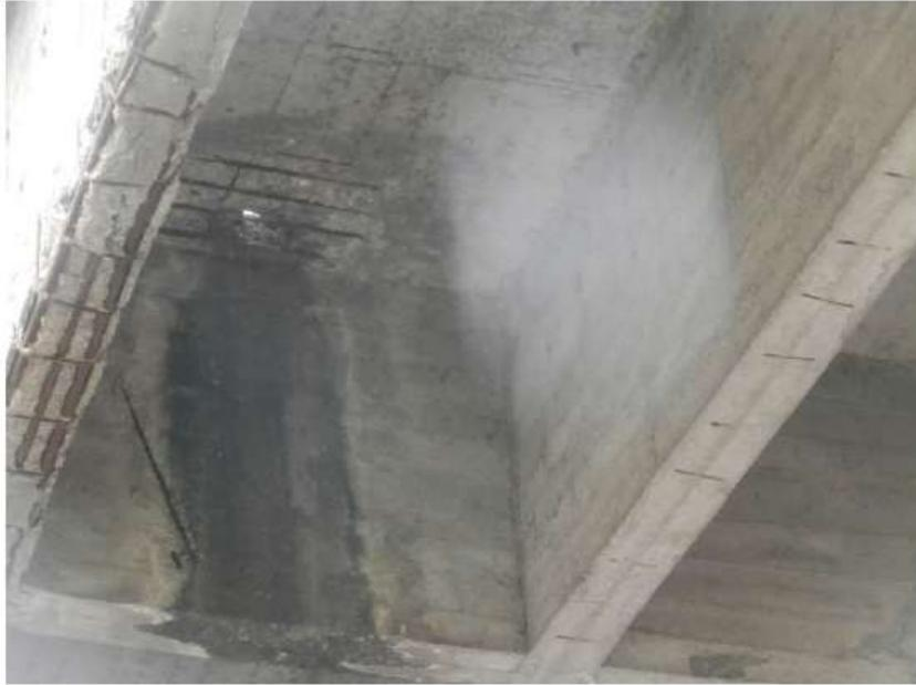
*Figura 2: Ammaloramento dei traversi in CA in corrispondenza degli scarichi*
