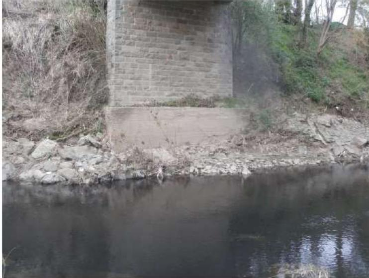
*Figura 12: pila scalzata*
