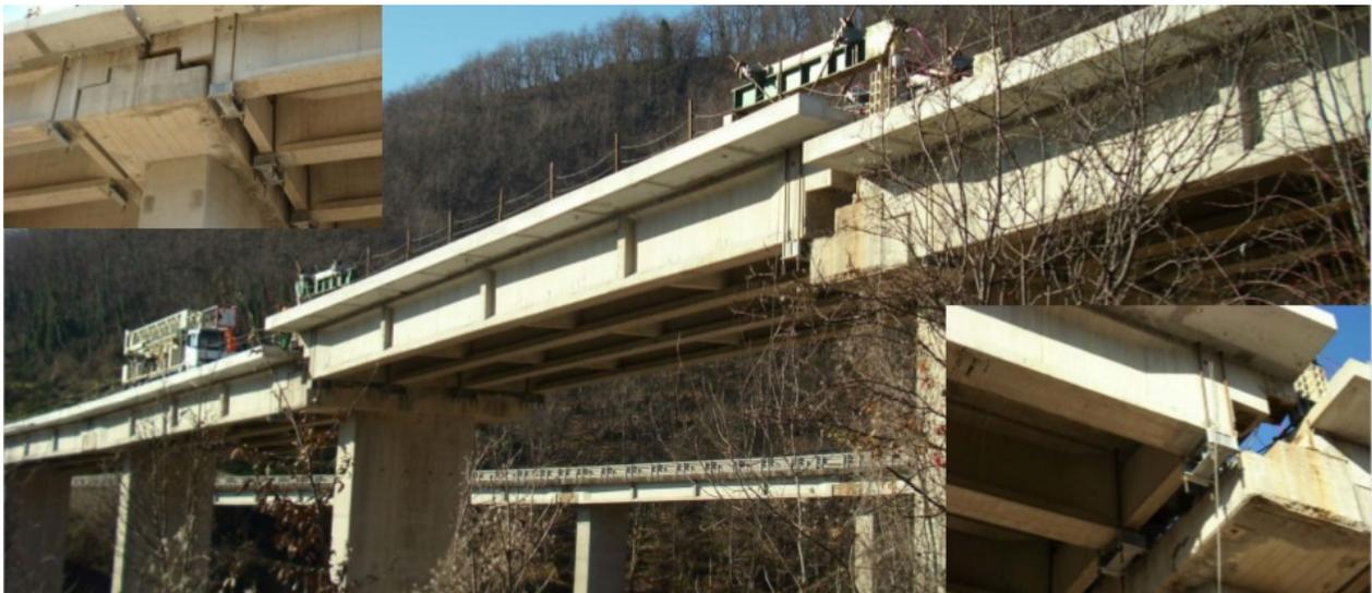
Figura 10: Esempio di sollevamento dell'impalcato centrale
