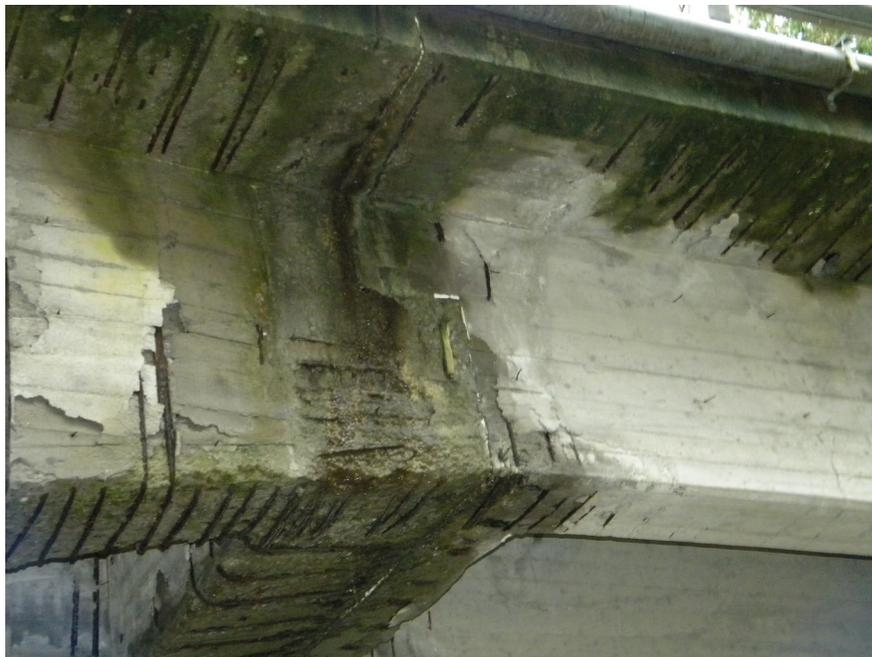
*Figura 1: Ammaloramento delle travi in CA in corrispondenza del giunto dell’impalcato*
