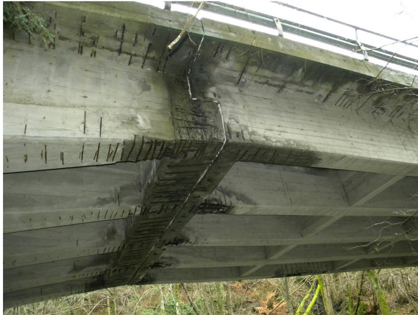
*Figura 2: Ammaloramento delle travi in CA in corrispondenza del giunto dell’impalcato*
